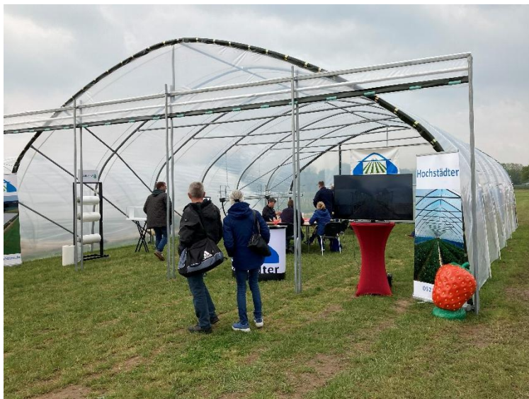
Gotisk tunnelform. Bemærk tværstivere i toppen, samt en dør som kan rulles op og ned.
